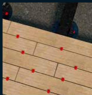
Les espaceurs de lames permettent d'obtenir un espacement régulier des lames pour terrasse. Cet accessoire pour terrasses en bois permet de prévenir les mouvements naturels du bois pouvant détériorer l'installation, favorisent la bonne circulation de l'air et l'évacuation de l'eau. L'espaceur de lame pour terrasse est composé de 4 côtés d'épaisseurs différentes : 4, 5, 6 ou 7 mm.
