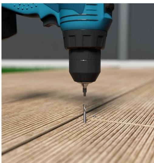
Vissez à 20 mm du bord de lame (dans le sens de la largeur)
