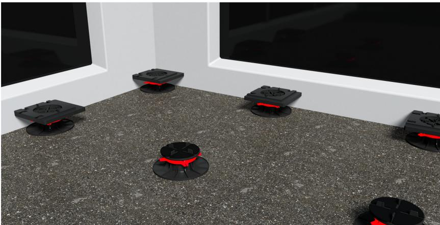
Poser tout d'abord les plaques à dalle sur les plots de périphérie et contre les murs, puis mettre une cale amortisseur antibruit sur tous les plots et les plaques à dalle.
